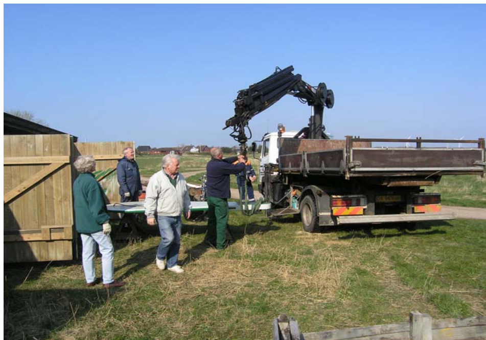
Transport af materiel fra arbejdsskuret til oprigning.
